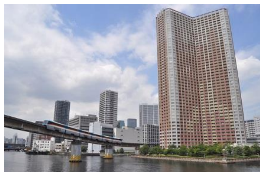
浜松町～天王洲アイランド間を走る東京モノレール羽田空港線の車両。 運河の上や高層ビルの間を縫うように走る区間で、雄大な景色が楽しめます。
